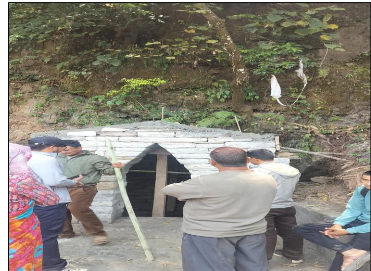
ऐतिहासिक नौलो पुनः निर्माण
