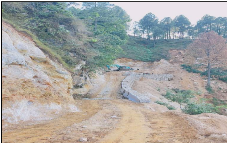
जोलजिवी, चौकी धरमपानी साननीचोरा खेतार सडक निर्माण
